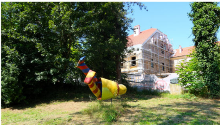
Dvorac umjetnika Oršić - Jakovlje za vrijeme konstrukcijske obnove, FOTO: AM / Blago & misterije
