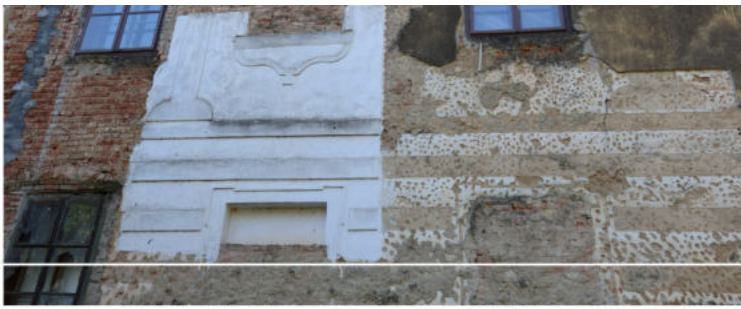
Detalji obnovljene fasade / Dvorac umjetnika Oršić - Jakovlje, FOTO: AM / Blago & misterije
