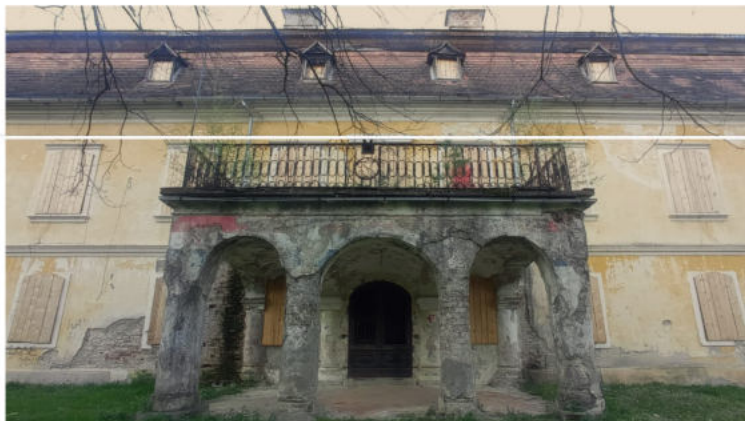
Dvorac Trenkovo. FOTO: AM. / Blaga & misterije
