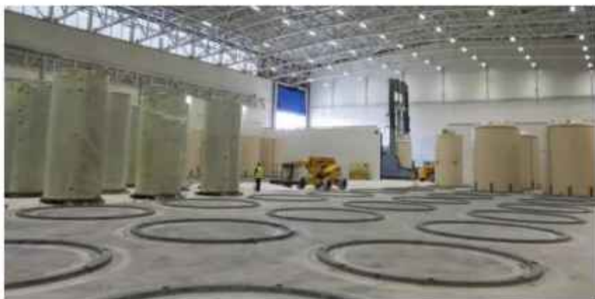
Suho skladište za istrošeno radioaktivno gorivo u NE Krško (izvor: NE Krško)
