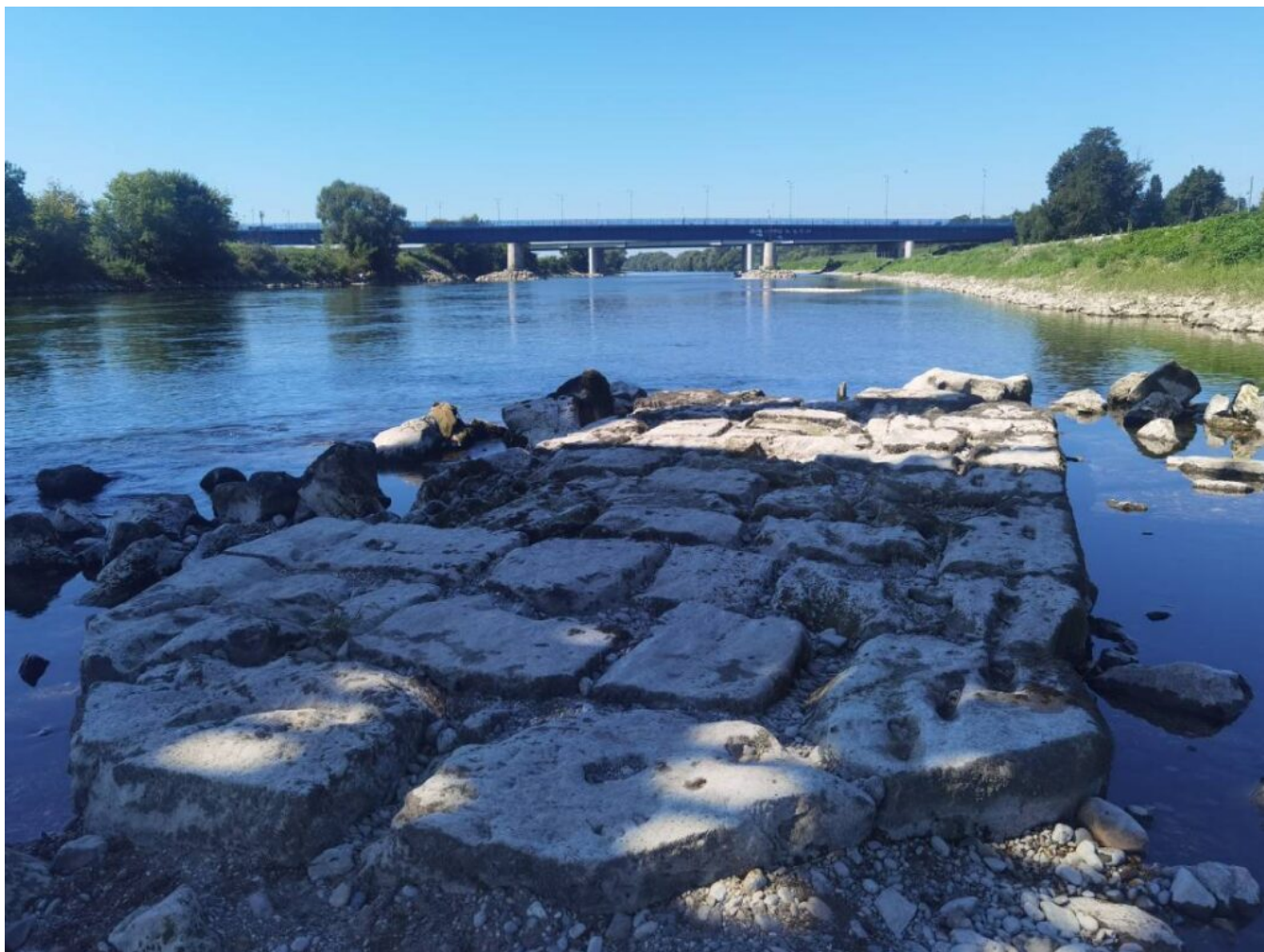
Temelji pilona najstarijeg zagrebačkog željezničkog mosta
