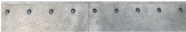
Taktilna polja upozorenja čepaste strukture na stubištu jedne javno-poslovne zgrade u Zadru.
