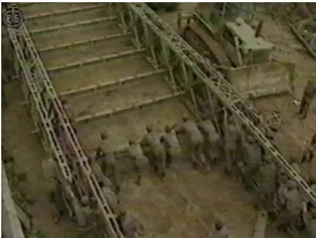
Radiotelevizija Beograd snimila je JNA kako gradi pontonski most na kanalu Strug kraj Stare Gradiške
